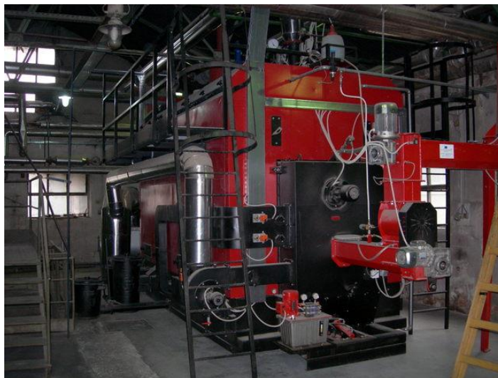
Slika 11: Nov kotel na lesno biomaso v družbi Kopitarna Sevnica d.d.
