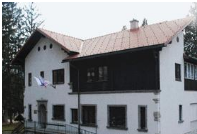
Slika 9: Stavba OŠ Ane Gale
