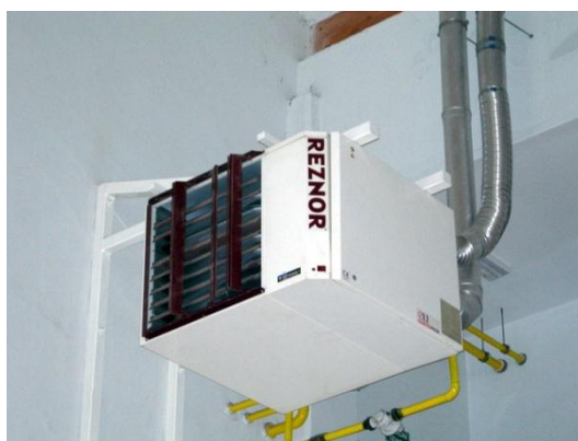
Slika 6: Plinski grelnik v telovadnici OŠ Blanca
