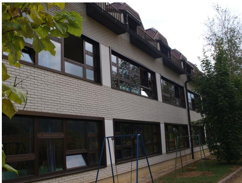
Slika 8: Pročelje OŠ Boštanj
