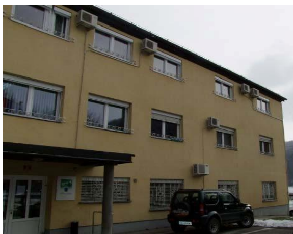
Slika 10: Stavba občine in UE Sevnica
