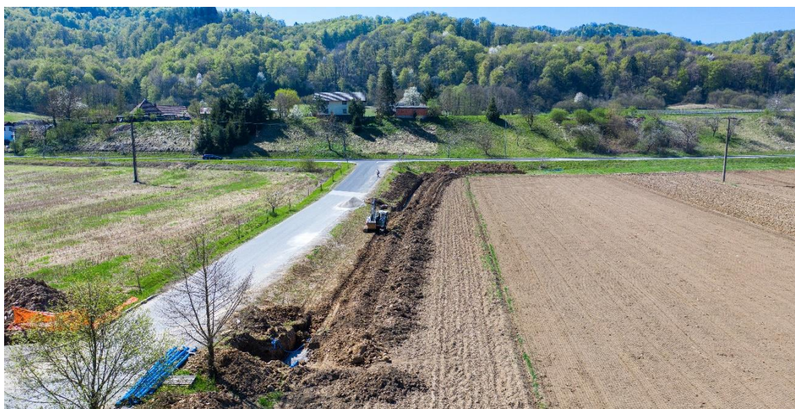
Polaganje vodovodnih cevi na Logu
