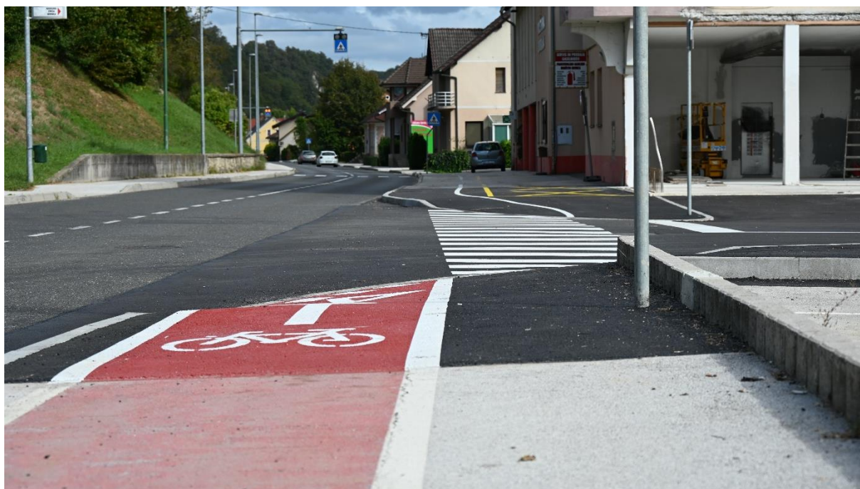
Uvoz na parkirišče pred Gasilskim domom Sevnica
