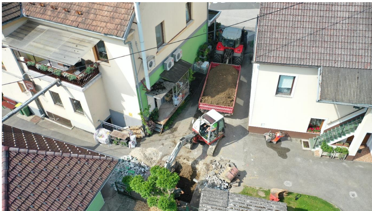
Gradnja fekalnega kanala v središču Sevnice
